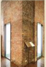
09 2階の修繕保存された煉瓦壁 (多目的ホールB)
